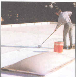
Полиэфирную смолу наносят и поверх уложенного холста, уплотняя ею все швы.
