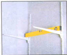
Парные кронштейны следует крепить на одной и той же высоте, проверяя их положение с помощью уровня.
