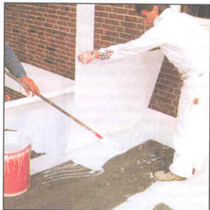
Полиэфирную смолу равномерно наносят меховым валиком на участок крыши и расстилают прочный армирующий холст по еще влажной массе.
