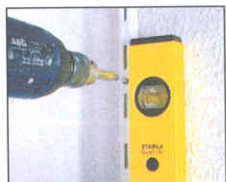
Настенные стойки выставляют по уровню и крепят шурупами с дюбелями.
